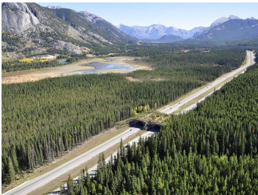
Рис. 1. Мост над эстакадой в Национальном Парке Банф, Альберта, Канада
