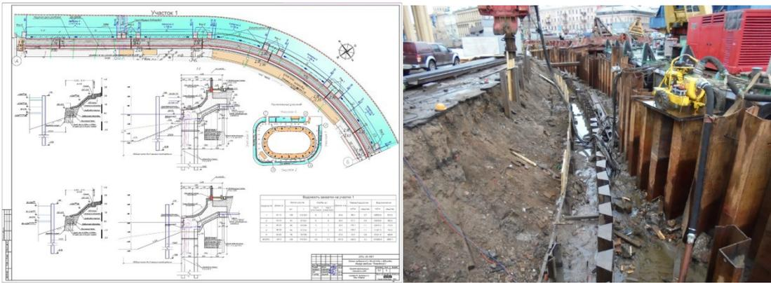
**Рис. 8. Проект усиления и выполнение работ по реконструкции «Кольцевой набережной»**
