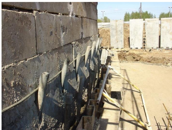
**Рис. 7. Усиление оснований здания анкерными устройствами**
