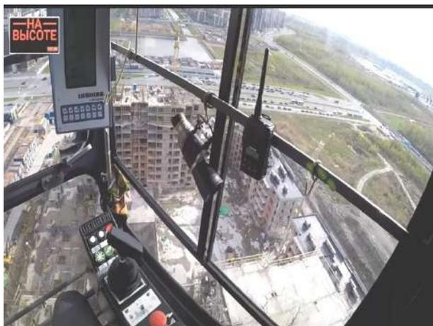
**Рис. 3. Использование монокуляра и радиосвязи на высотном кране**
